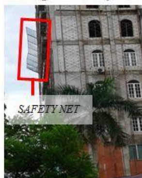
Gambar 2. Safety Net pada sisi kiri Gedung rektorat UNIBA
