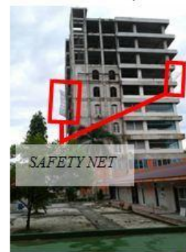
Gambar 3. Safety net pada sisi kiri gedung rektorat UNIBA
